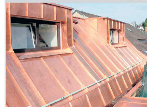
Dachsanieierung in Kupfer in der Altstadt von Luzern.
